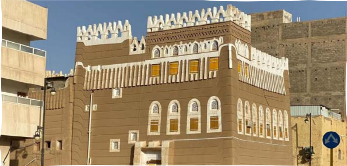
أحد المباني التراثية التي تم ترميمها من الأهالي بنجران
